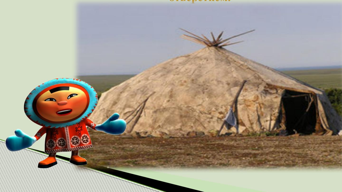
**Отличие яранги от чума в сложности её конструкции. Чум не имеет внутренних распорок, которые выгибают крышу. Также яранга значительно превышает чум по размеру. Внутри яранги к одной из горизонтальных перекладин (обычно у задней стенки) с помощью дополнительных шестов привязывался меховой полог. Полог являлся специфической особенностью жилища чукчей. По форме он напоминал ящик, перевернутый дном к верху. Обычно в яранге имелось не более четырех пологов.**
